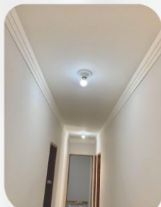
Molduras em Gesso
